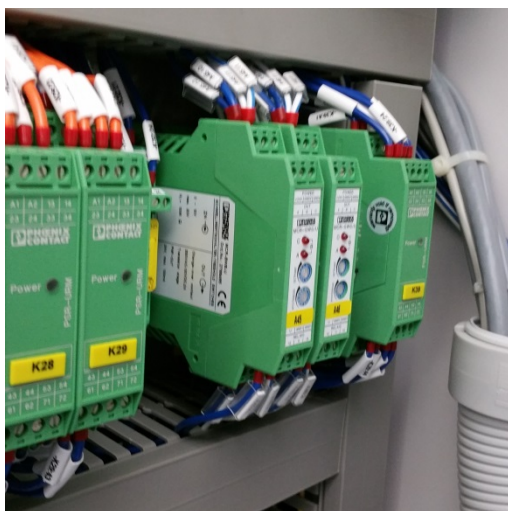
リレー式 操作側から発信されるパルスデータをレーザーの駆動装置へ変換するリレー
