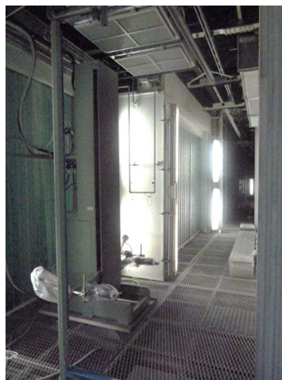
図 2-33 試作機の塗装工程部
