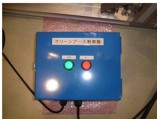
図 12. クリーンブース制御盤
