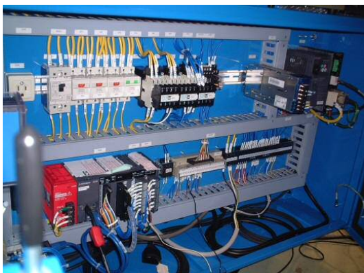
図 10. 露光装置制御盤
