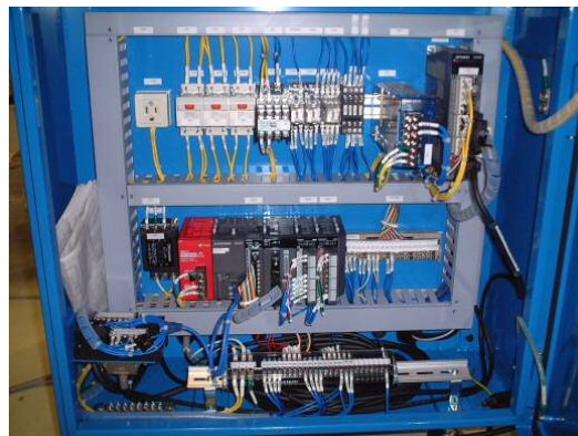
図 11. インク塗布装置制御盤
