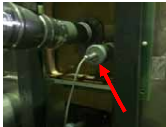
図 2-2-13 IRセンサーの取り付け
