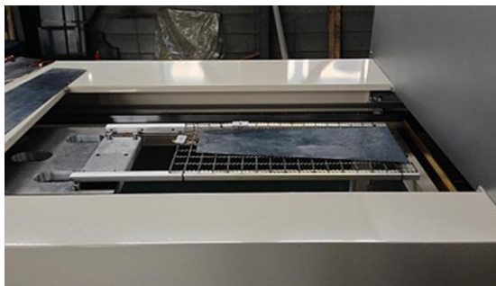
①CFRP 材の設置
