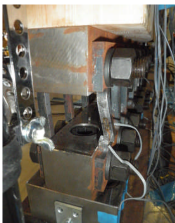
a) 側柱最外側ダンパーの破断例
