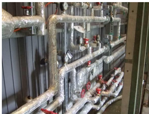
図 2-1-1-4 金型冷却システム
