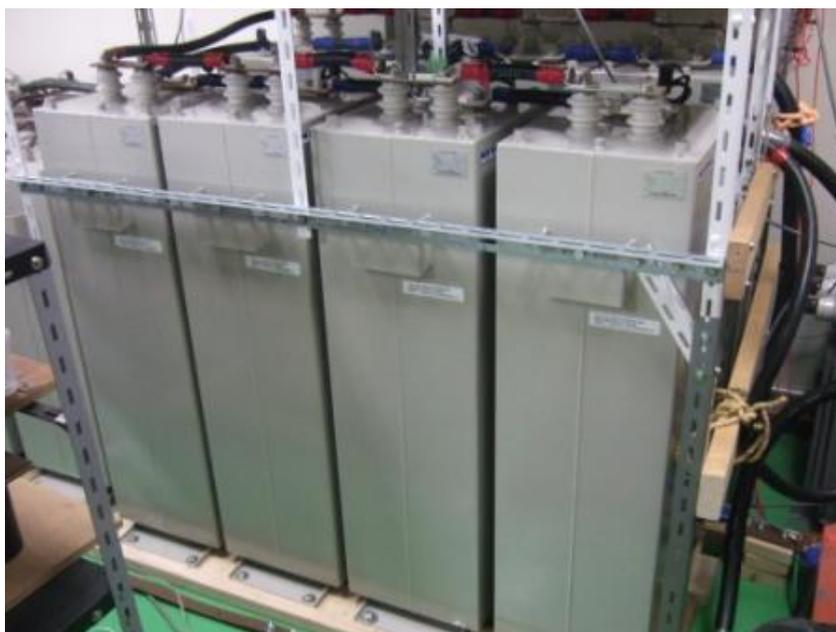
図8 コンデンサバンクの写真
