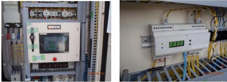
Fig.19 開発された新冷凍システム制御装置と設置状況（制御盤内の様子）
