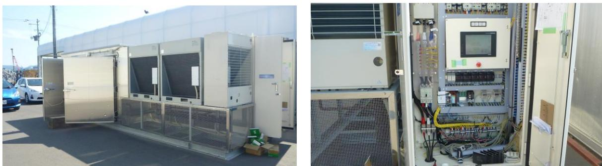
Fig.15 試験機（左側：凍結庫 右側：冷凍機器類）と制御装置類
