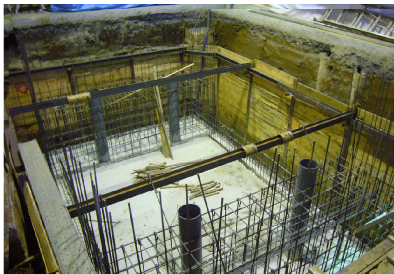
図 2-39 基礎工事の写真
