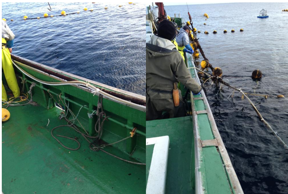
図 2-2-19 ロープを船上へ引き上げケーブルをロープへ結束
