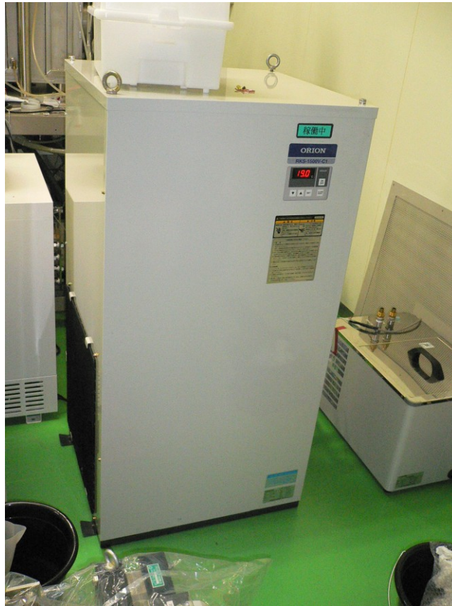
図 2-3-6. 循環式水槽と空冷式チラー（6 kW）
