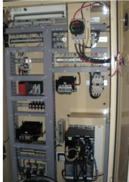
(b) 制御盤内部
