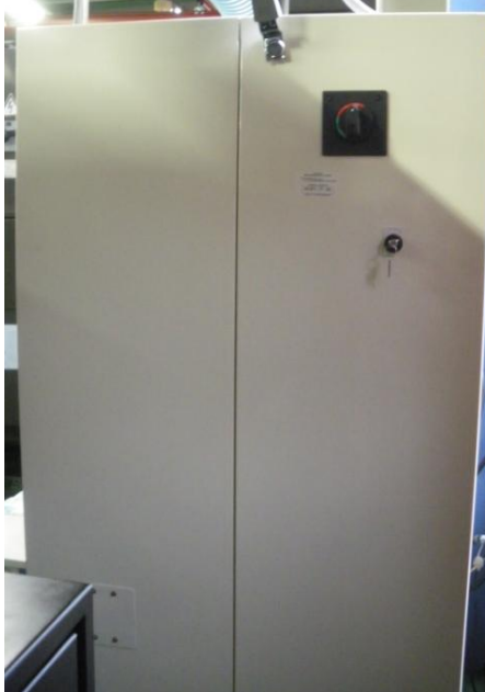
(a) 制御盤外観
