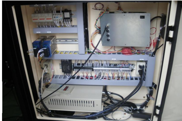
写真1 試作機に搭載したスピンドルユニット部制御盤
