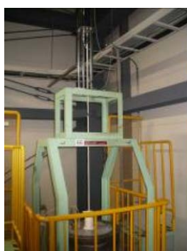
原料焼結炉ユニット
