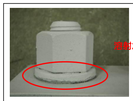
写真-36 未溶射部分が発生した試験体
