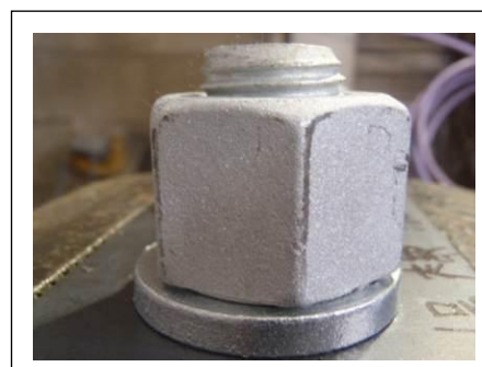
締め込み傷（深い傷）
