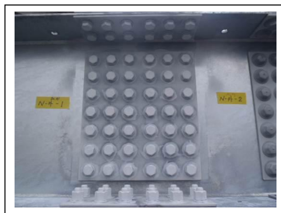
写真-14 1 ヶ月暴露後に溶射した状態
