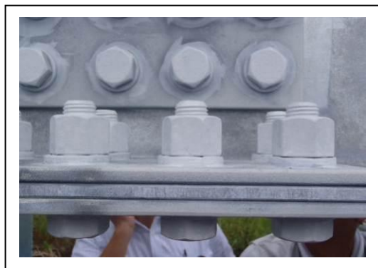
写真-15 ボルト、ナットの溶射状態
