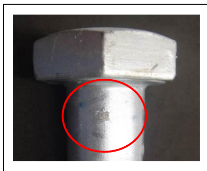
写真-16 ボルト（剥離部）
