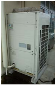
環境清浄化ユニット室外機
