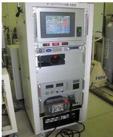
写真 3.1.2 CVD装置の制御系の外観。
