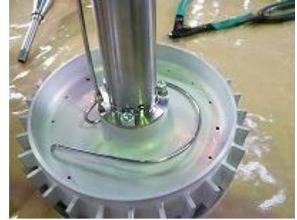
③潤滑配管組付け
