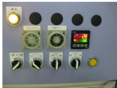
写真 4-3-2 装置制御盤部
