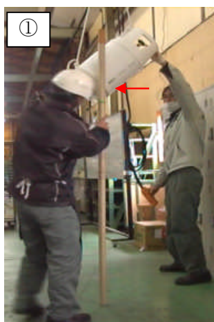
① 角度を固定し、1.5mのゲージで高さを確認
