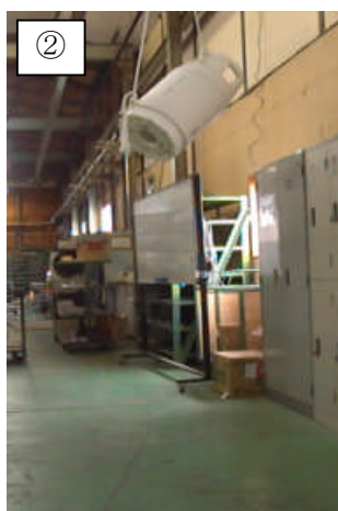
② 作業者は落下点から離れ、安全を確認
