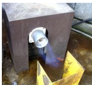
バイオガスバーナー燃焼のようす
