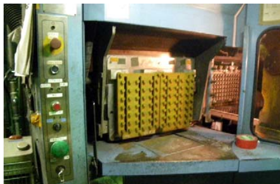
写真 2.4.3.2 中子振込み機（コアフレーム）セット状況
