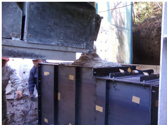
図 5-4 ニカセラコ泥しょうの鑄込み
