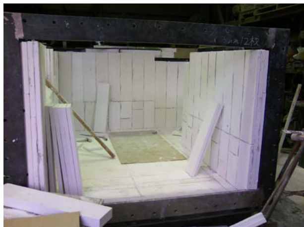
図10 鋼鉄製炉体枠への断熱材の敷設
