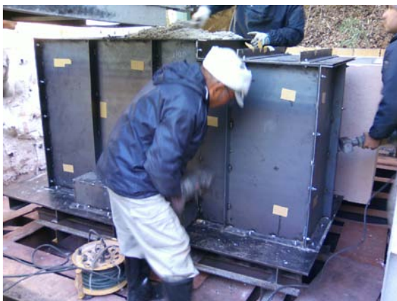
図 5-5 バイブレーターによる充填・脱泡
