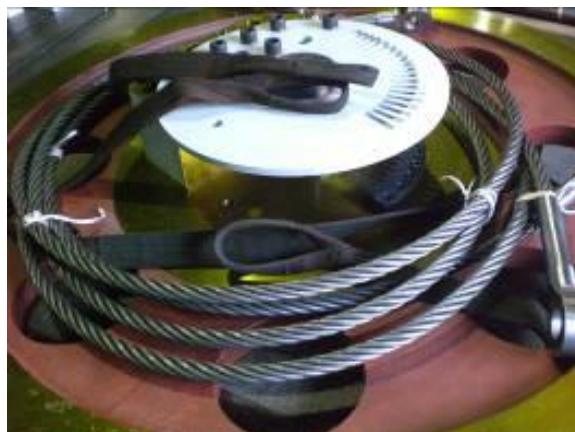
(4) プーリの据付
