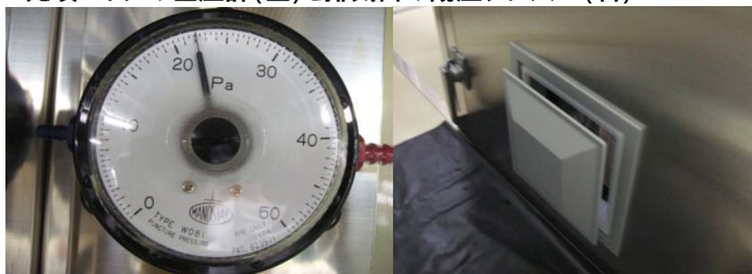
製品を開放して扱う充填エリアは+20Pa以上の高気圧状態により差圧制御されており、それは差圧調整用の陽圧ダンパーにより実現されている。陽圧ダンパーは風圧の発生しない非稼働時は内部の重りにより、密閉される。
