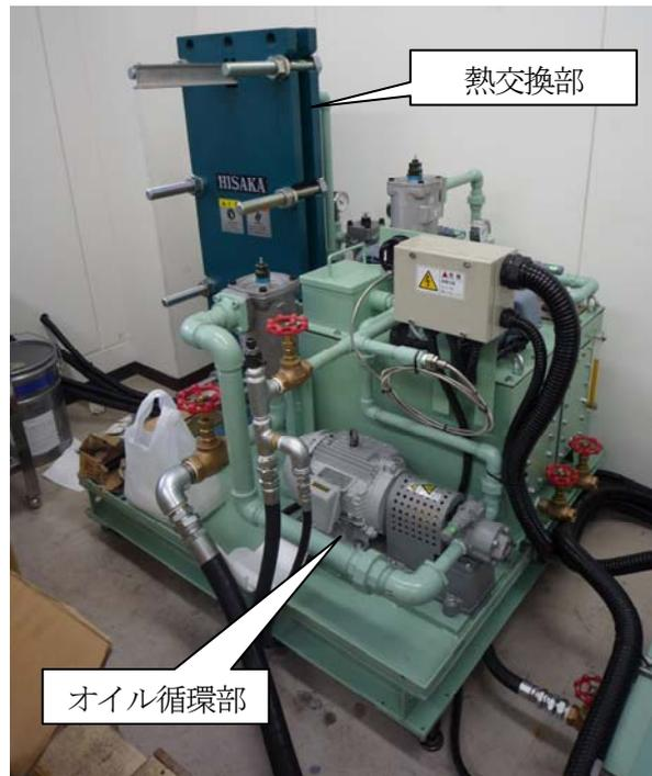
図3. 強制給油装置外観写真
