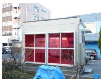
写真2-5-1-1 ハイブリッド型植物栽培ユニット外観
