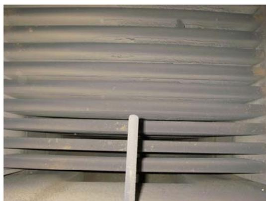
図 48 伝熱管最上段上面の状況
