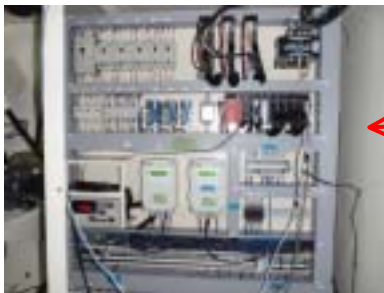
速度/トルク制御用の制御盤
