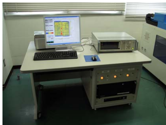
写真 2 超音波探傷器操作盤
