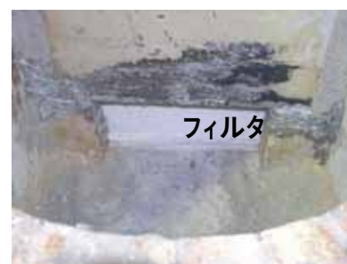
図 2-3-2 改良型フィルタ設置底
