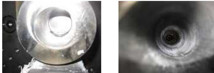
写真 2-1-6 スリーブ内部
