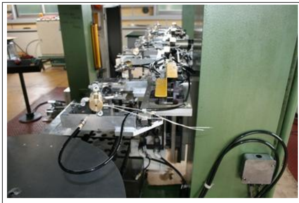
図 2-11 プレス機械に設置した自動供給搬送装置
