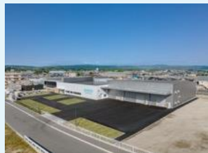
第三工場外観
