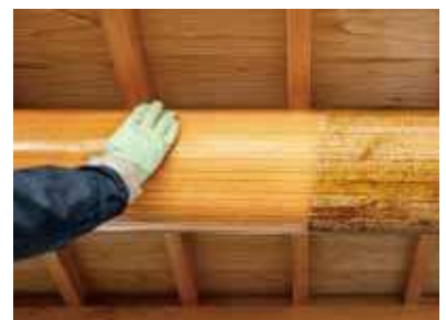
「常若施工」に必要な技術にチャレンジ
