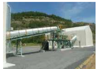
八戸バイオマスプラント
