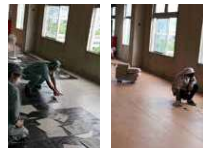
5S活動例 食堂床修繕
