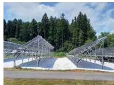
太陽光パネルガラス防草・反射材施工例
