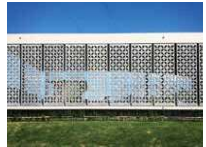
HPC施工事例
