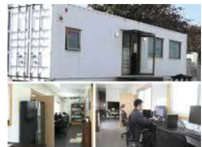
中国で内装を仕上げたコンテナハウス
