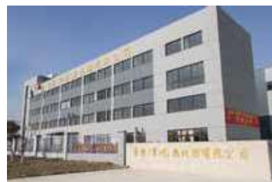
中国工場の全景
