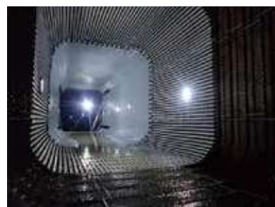
銅製リングとPE部材で管更生
