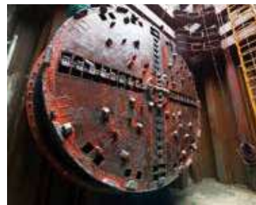
3,000mmマシンによる浸水対策下水路
