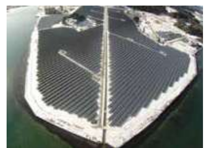
石川県七尾市の太陽光発電所
