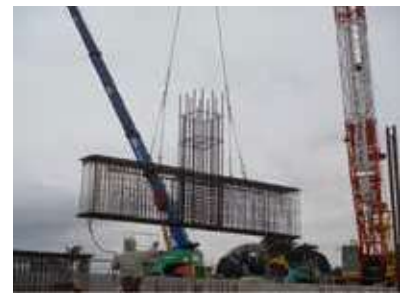
プレハブ工法による生産性向上
