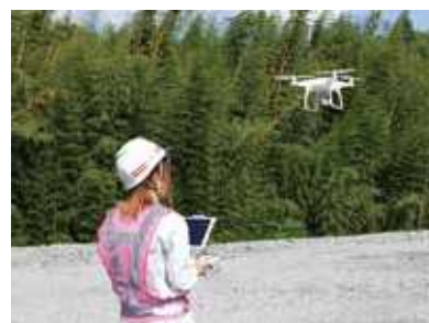
ICT施工で活躍する女性スタッフ
