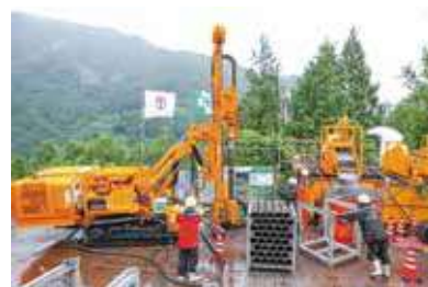
災害復旧工事の様子
