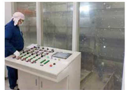
ネパール人管理職による設備の操作
