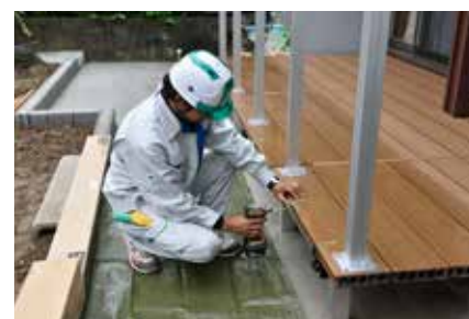
ユニットビルダーによる安心安全な施工
