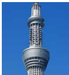
超高層ビルで使用されるスチール製支持材
