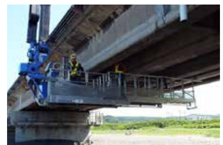
コンクリート構造物の橋梁の検査
