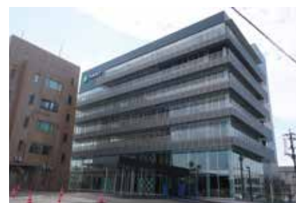
西原商会グループ本社ビル
